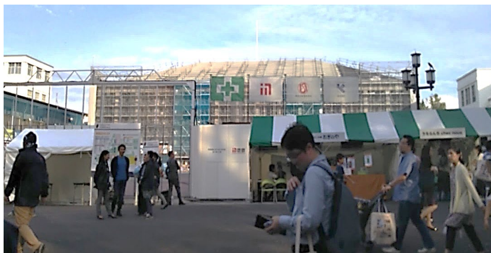
建設中の新日吉記念館、2020年3月竣工予定
