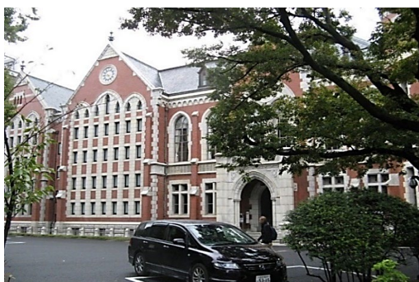
耐震工事の終わった図書館旧館（重要文化財）
